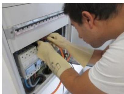
Figura 4 – Estagiário Daniel Marques em apoio a Auditoria Energética na Santa Casa do Montijo
