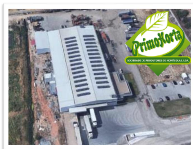
Figura 31 – Vista aérea da central fotovoltaica
