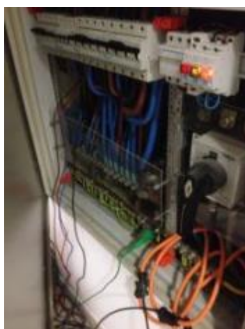
Figura 32 – Colocação analisador de rede na AHBV da Moita
