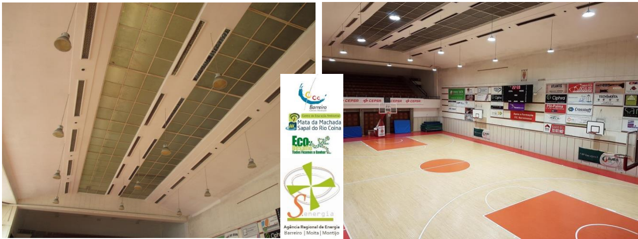
Fig. 4 – Sistema de iluminação interior antes e depois da intervenção do projeto Eco-Desafio
