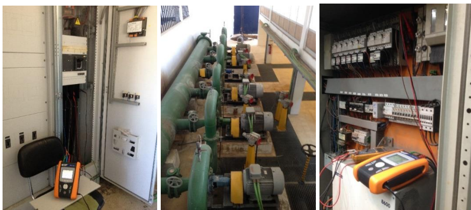
Figura 5 – Recolha de dados com analisador de energia para a elaboração das candidaturas
