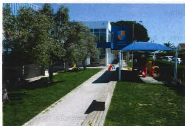
Figura 14 – Edifício Topchoice – Rental & Real Estate Activities and Financial Advisory, Lda, no Campus da Escola Profissional da Moita
