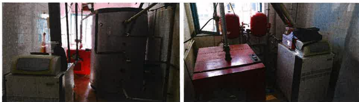
Figura 8 – Instalação antes e depois da intervenção
