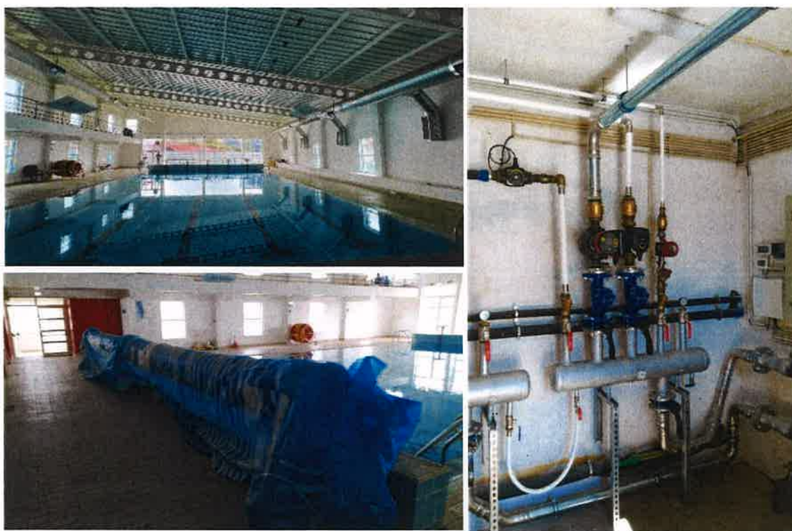
Figura 6 – Modernização de sistemas técnicos da Piscina Municipal de Alcochete
