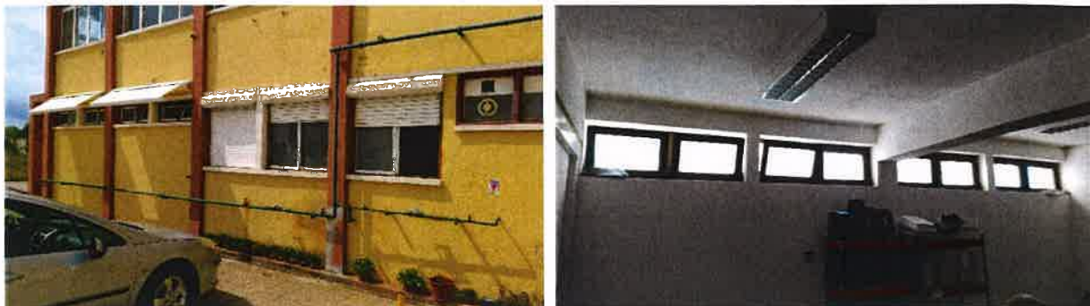
Figura 31 – Instalação da REEFOOD – Barreiro
