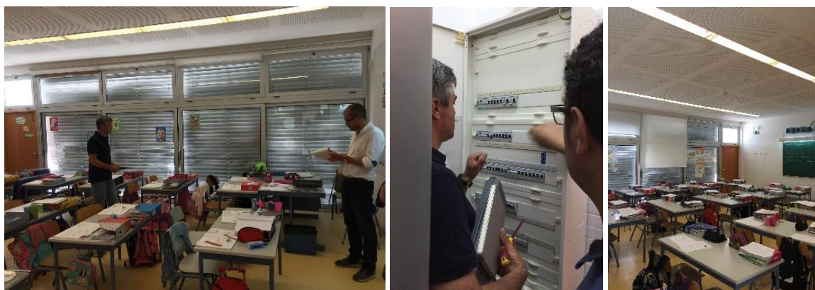
Figura 13 – Registo fotográfico das medições realizadas pelo ISQ pré intervenção
