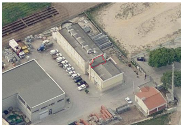
Figura 19 – Imagem da cobertura do edifício dos serviços técnicos de Alcochete
