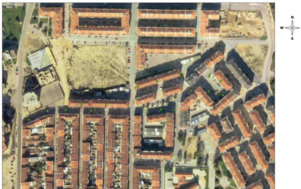
Rua de Diu - Baixa da Banheira - Colocação/substituição de luminárias existentes por outras de vapor de mercúrio
