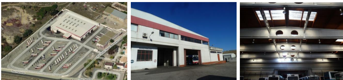
Fig. 3, 4 e 5 – Edifício Sede e Terminal dos Transportes Colectivos do Barreiro (TCB)
