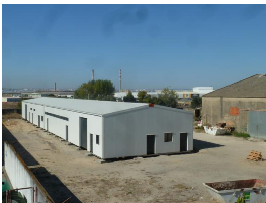
Fig. 7 – Novo pavilhão dos Serviços Municipalizados dos Transportes Colectivos do Barreiro
